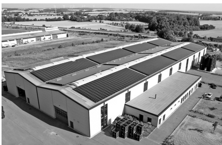
Rys. 9 Przemysłowe zastosowanie paneli słonecznych Źródło: [13]
